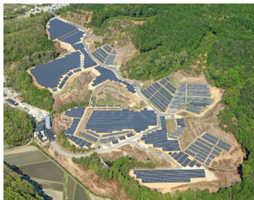
京都・亀岡メガソーラー発電所
